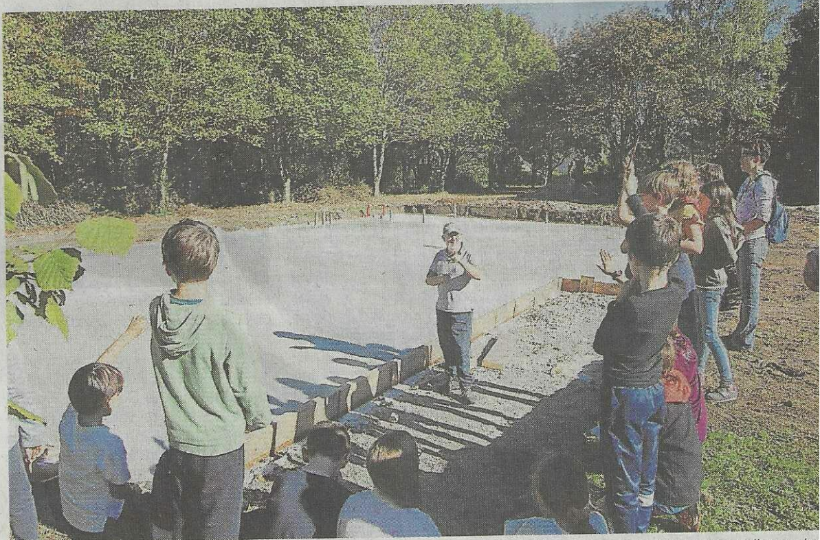
Les élèves de CM1 et CM2 de l'école Philippe-Meirieu suivent tout au long de l'année la construction d'une salle passive au camping du Hallate. PHOTO : OUEST
